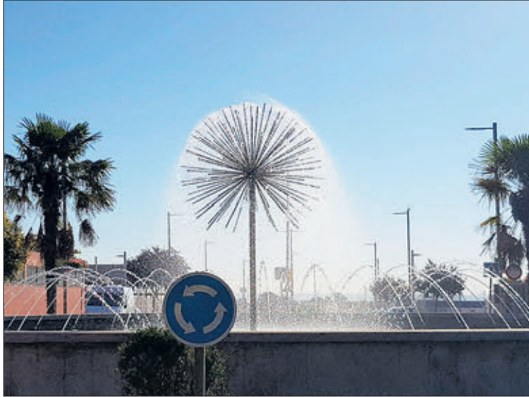
La fuente de la Esfera sufrió importantes daños por el temporal Filomena.
