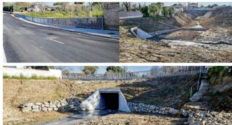
hormigón y prefabricados originales y de zahorra artificial yesollera aportada para conformar el cimiento soporte del hormigón de limpieza y nivelación. Además, se han repuesto los servicios afectados y reconstruido los pavimentos de
