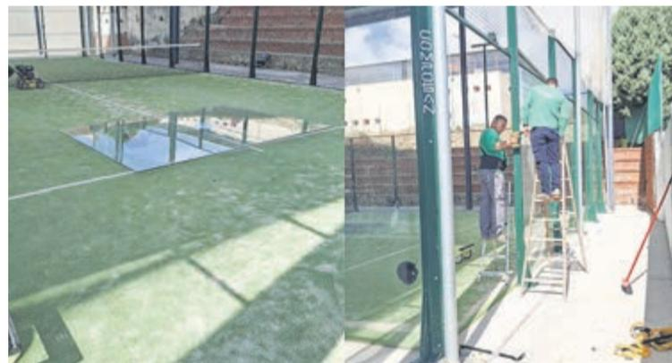
sustitución del pavimento en mal estado, realizando un saneado en las zonas deterioradas y arreglo del perímetro, así como el pintado del muro de hormigón perimetral. Mantenimiento de las dos pistas de pádel municipales, con cambios de neoprenos en las juntas de vidrios y cepillado del césped artificial para mantenerlas en buenas condiciones de uso.
