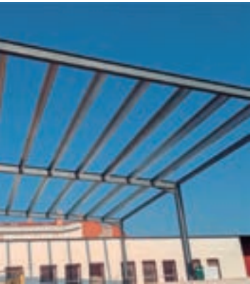
Las obras del nuevo porche municipal situado en la calle Roble
